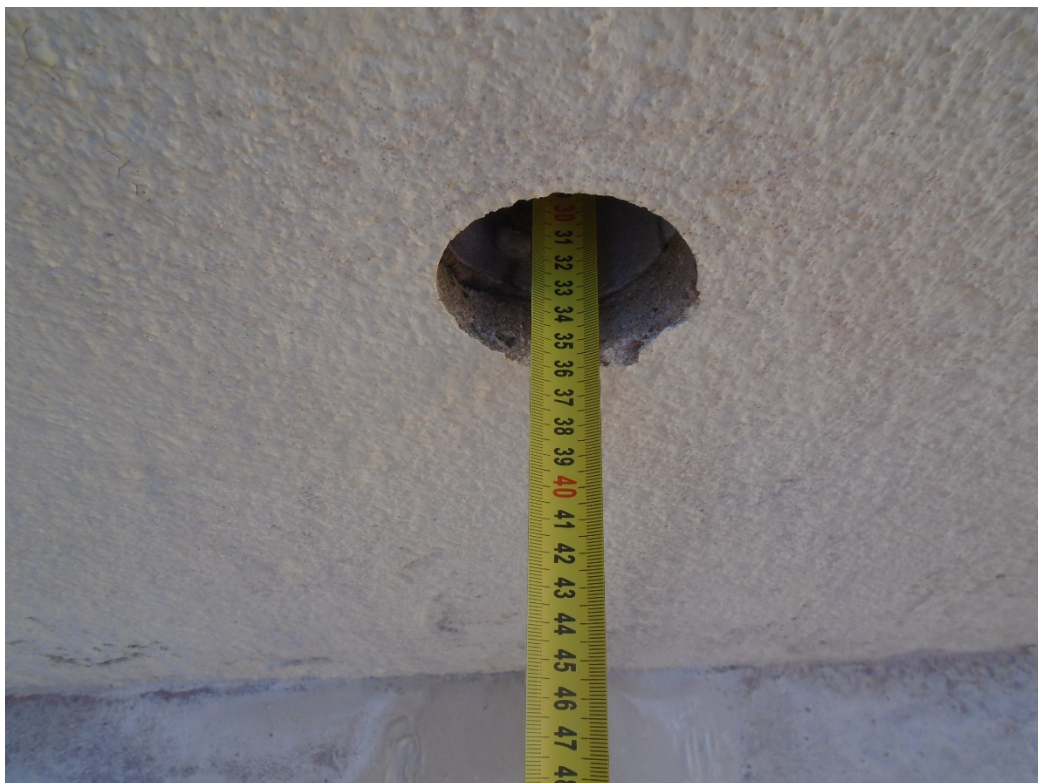
Foto 6: Perforación de extracción de testigo de muro TM2.
