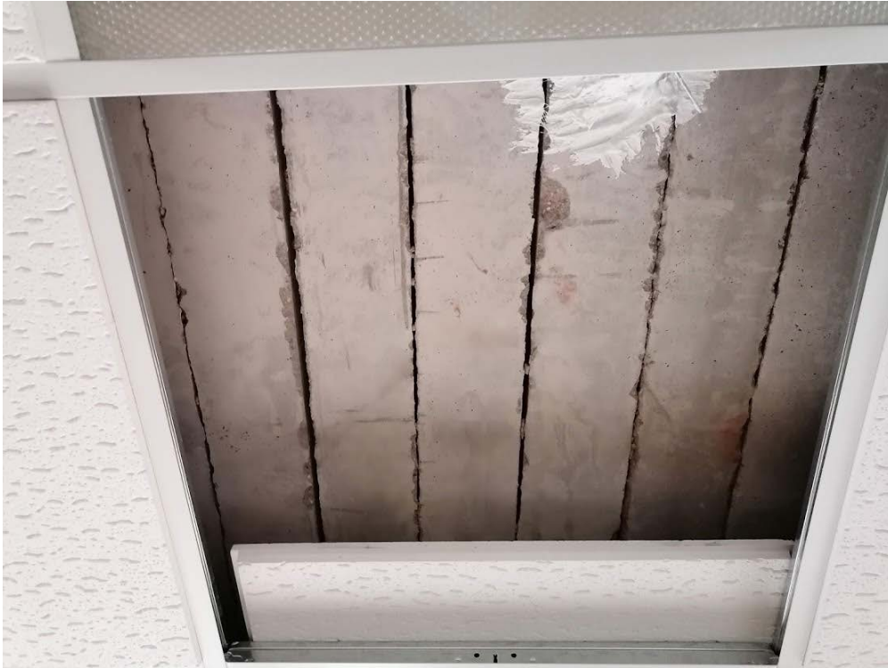
Foto 11: Detalle del forjado en la zona del comedor bajo el pasillo de 3,50 m de ancho. Viguetas adosadas una al lado de la otra. Canto del forjado más acabado de 47 cm.
