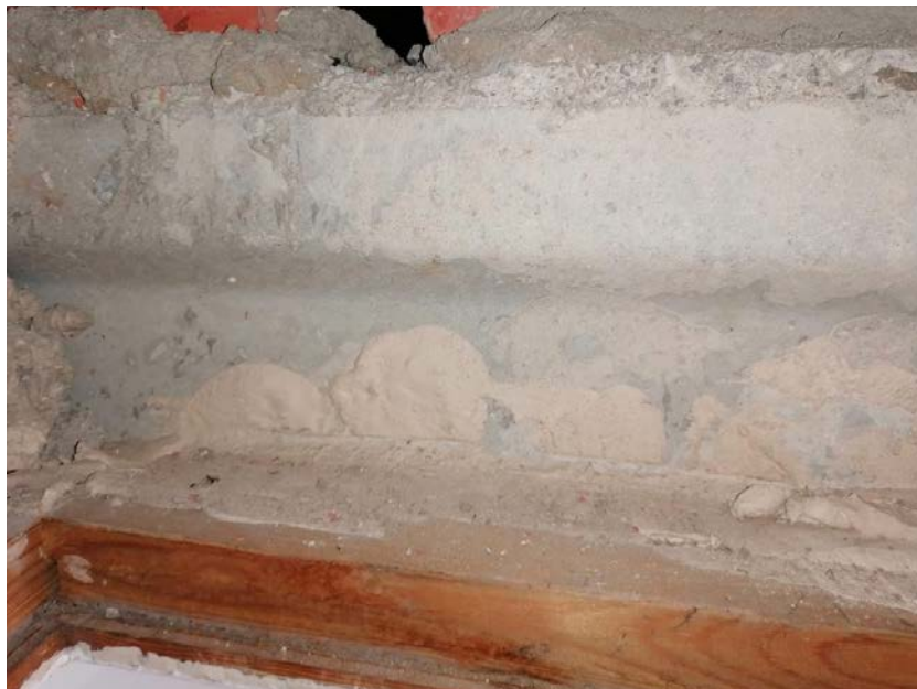
Foto 18: Forjado 3 de soporte de la cubierta. Canto 23 cm. Vigueta de hormigón prefabricado.
