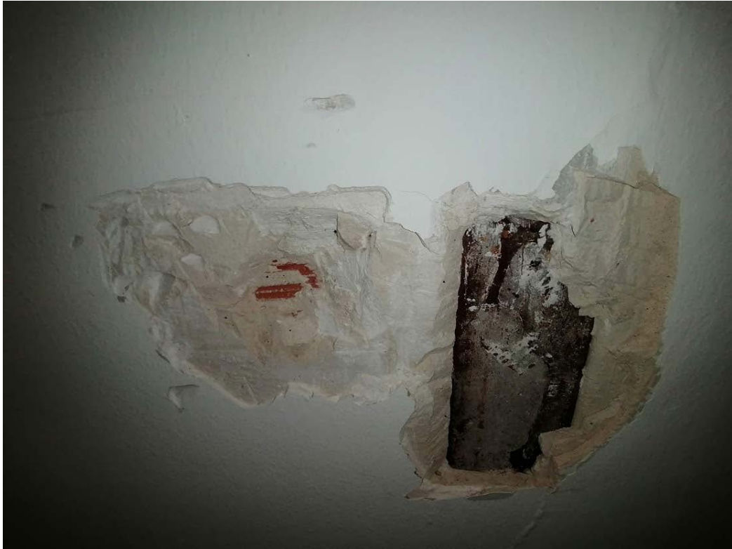
Foto 16: Zona del comedor con vigas de acero de 90 mm de ala inferior. Distancia entre ejes de 83,50 cm. Se encuentran en buen estado y no presentan óxido.
